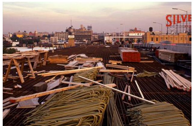
6 Stahlbrücken, New York 1988 © Stephan Erfurt
