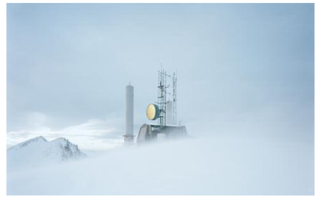
10_ Military Facility V, Norwegische Streitkräfte, Andøya, Norwegen, 2020. Aus der Serie The Polar Silk Road © Gregor Sailer und VG Bild-Kunst, Bonn 2022
