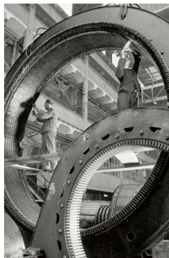
A14: Dr. Paul Wolff, Ständer von Wasserkraftgeneratoren. Siemens-Schuckert, Berlin 1936 © Dr. Paul Wolff & Tritschler, Historisches Bildarchiv, Offenburg
