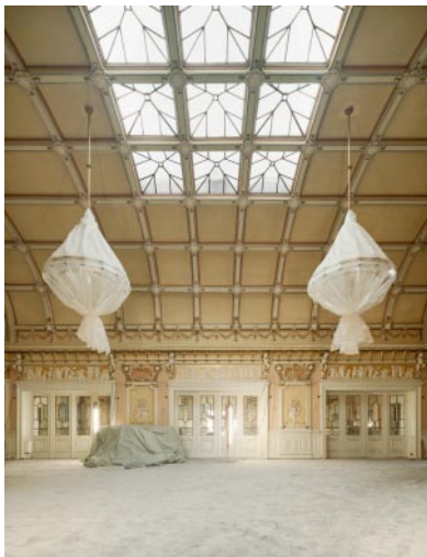
09_Sanierung und Umbau der Stadthalle, Ballsaal, 2025 © Brigida González
