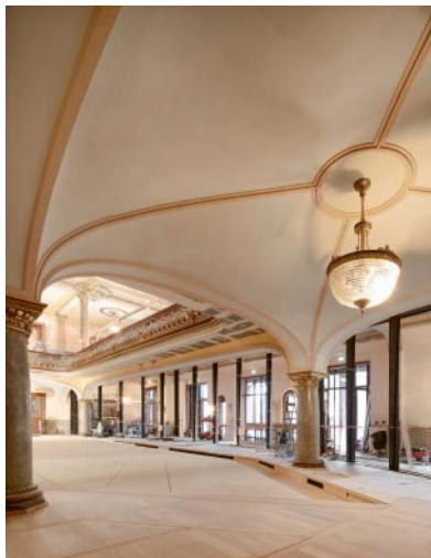
03_Sanierung und Umbau der Stadthalle, Großer Saal, Umgang im Parkett, 2025 © Brigida González, Stuttgart
