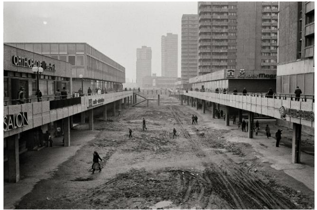
08 Versorgungseinrichtungen im Wohnkomplex IV, Halle-Neustadt, 1983 © RUDI MEISEL
